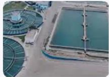
Plantas de tratamiento de agua
